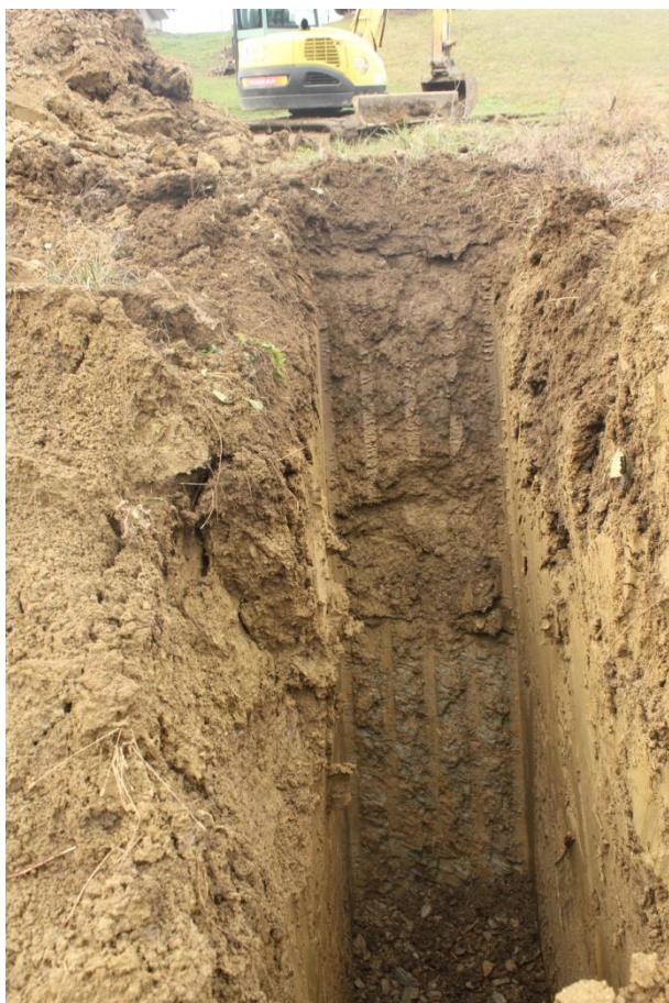
Sonda 4 Izkop v območju ceste za podporni zid
