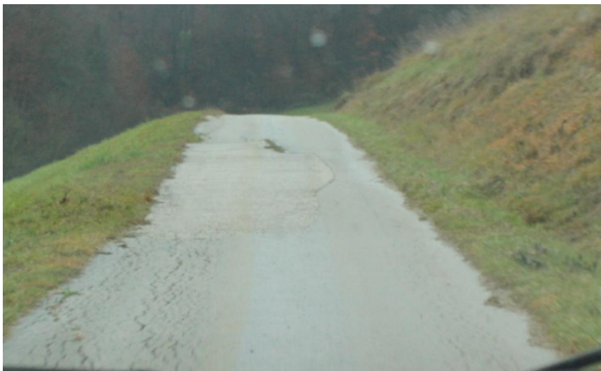
Slika 2. Pogled v območje večjih deformacij in vidna nestabilnost desne brežine
