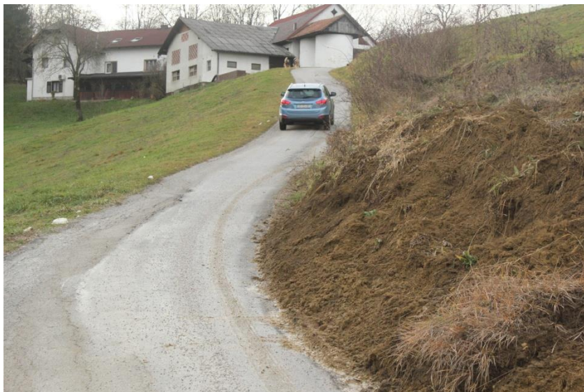
Slika 3. Pogled na poškodbe v zadnji klanec proti turistični kmetiji Bizjak
